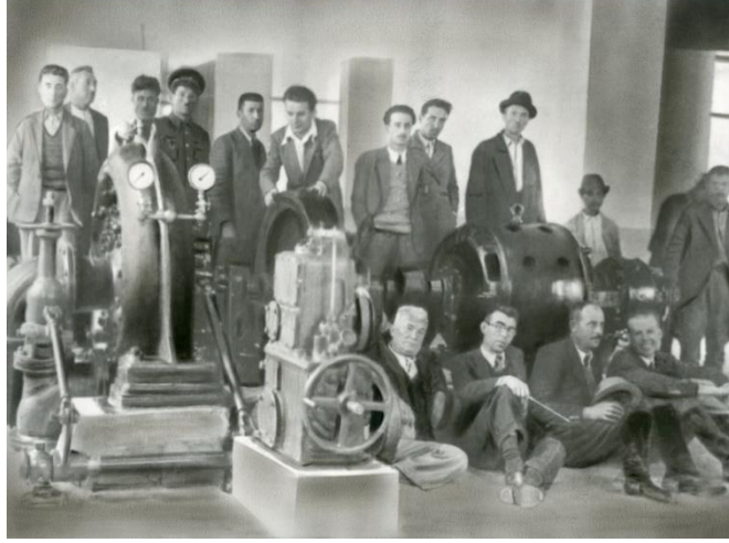
Şekil 5.129: Gökpınar II Hidroelektrik Santrali İçi-Macaristan'dan gelen trübün (Haytoğlu 2018)
