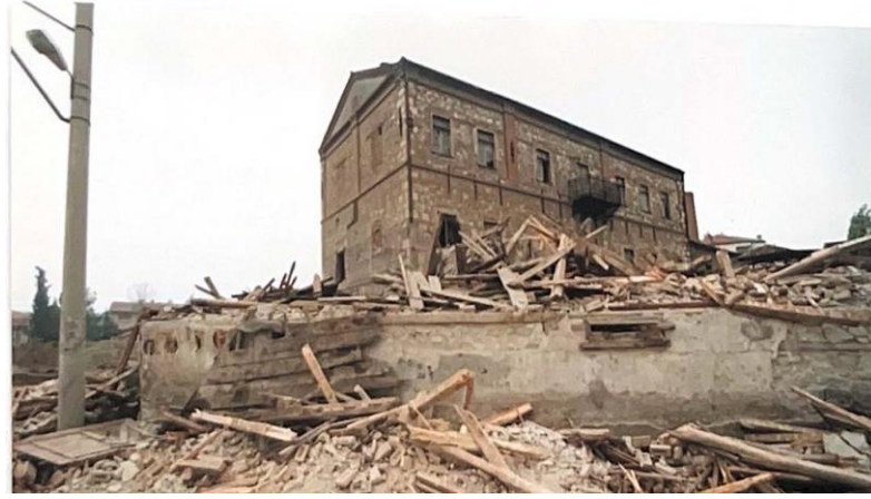
Şekil 5.15: Külahçioğlu Un Fabrikası İdari Binası Ek Yönetim Binası Yıkıldıktan Sonra (Denizli İl Kültür ve Turizm Müdürlüğü Arşivi)
