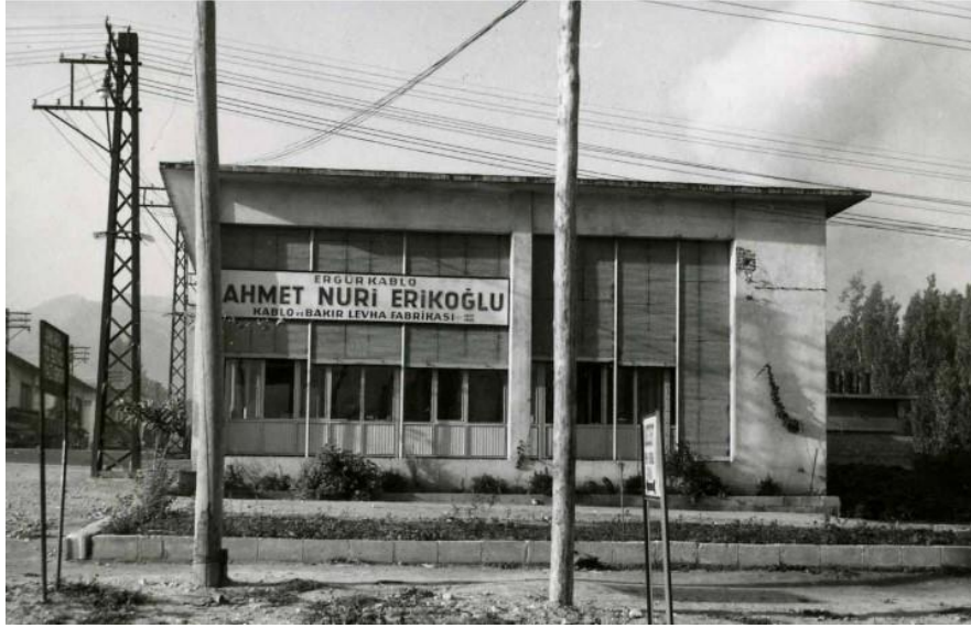
Şekil 5.83: Ergür Kablo Atölye yapısı ( https://www.erikoglu.com/tarih.php )
