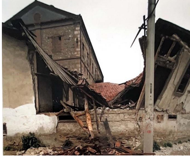
Şekil 5.14: Çöken Ek Yönetim Binası. 1996 (Denizli İl Kültür ve Turizm Müdürlüğü Arşivi)
