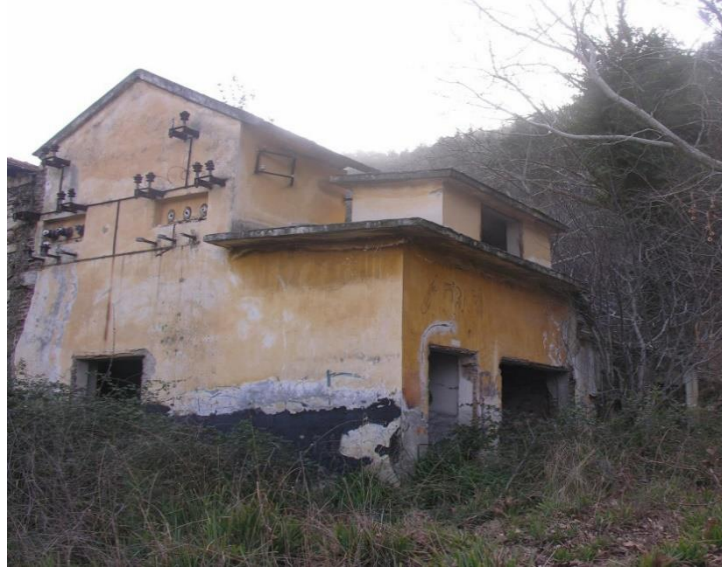
Şekil 5.126: Gökpınar I Hidroelektrik Santrali, 8 Şubat 2018 (Haytoğlu 2018)
