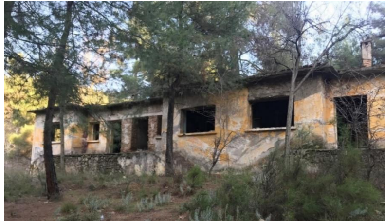
Şekil 5.128: Gökpınar II Hidroelektrik Santrali işçi lojmanı (Yazar Arşivi 2022)
