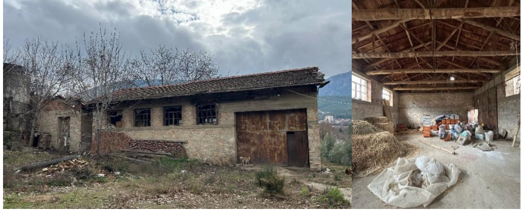
Şekil 5.29-30: Kaşıkçı Un Fabrikası Deve Damı (Yazar arşivi 2024)
