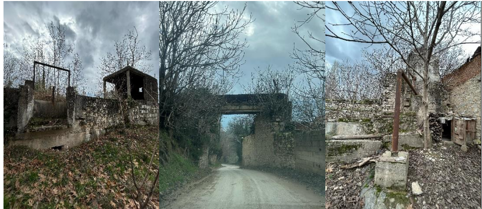
Şekil 5.33-34-35: Kaşıkçı Un Fabrikası, Su Kuyusu-Köprü- Suyun Döküldüğü Havuz (Yazar arşivi 2024)
