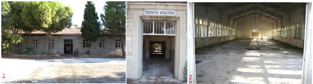
Şekil 5.115-16-117: Taş Atölyeler'in restore edilmeden önceki durumu. (İzmir Rölöve ve Anıtlar Müdürlüğü)
