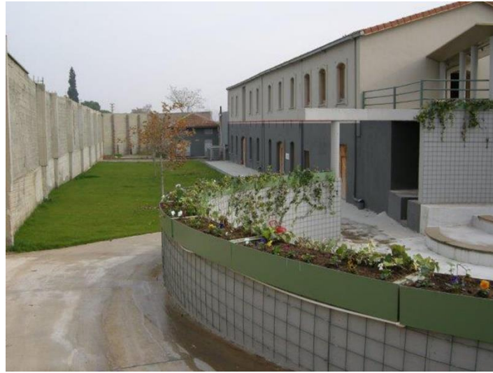
Şekil 5.23: Karabacak Un Fabrikası-Abaloğlu Çırçır Fabrikası- Merkezi Zaferiye Abaloğlu Bilim ve Sanat Merkezi Bahçesi ( https://www.arkiv.com.tr/proje/zaferiye-abalioglu-bilim-ve-sanat-merkezi/7602 )
