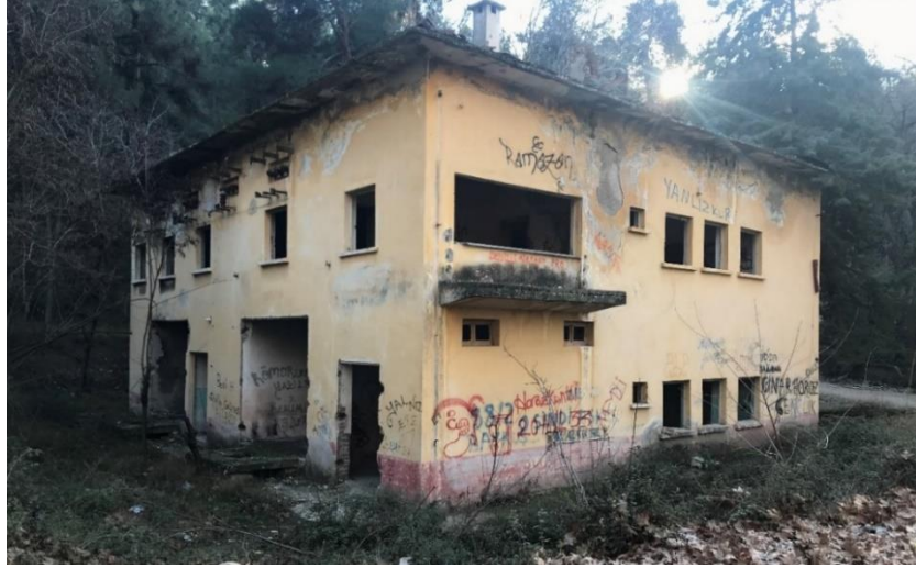
Şekil 5.130: Gökpınar II Hidroelektrik Santrali (Yazar Arşivi 2022)
