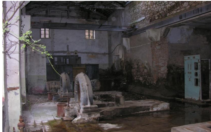
řekil 5.125: Gkpınar I Hidroelektrik Santrali i mekndan grnř, 8 řubat 2018 (Haytoęlu 2018)
