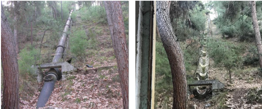
Şekil 5.132-133: Gökpınar II Hidroelektrik Santrali cebri borusu aşağıdan yukarıya görünüşü (Haytoğlu 2018, Yazar Arşivi 2022)
