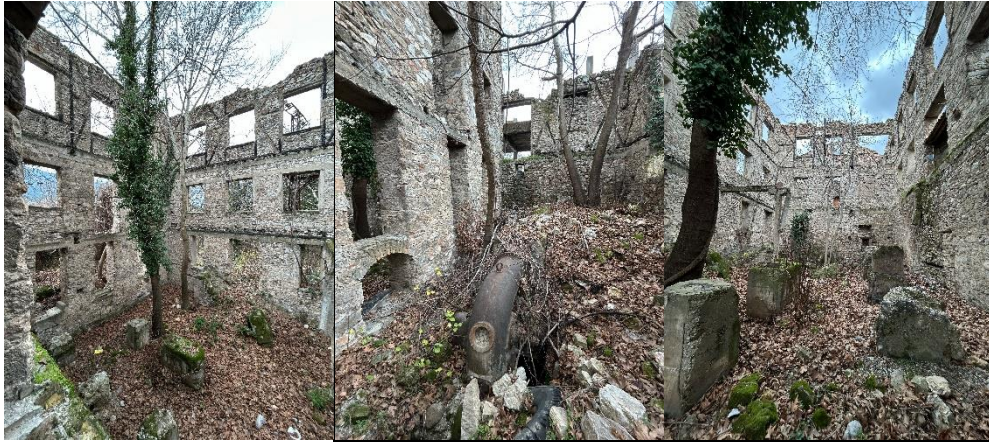
Şekil 5.26-27-28: Kaşıkçı Un Fabrikası İç Mekân (Yazar arşivi 2024)
