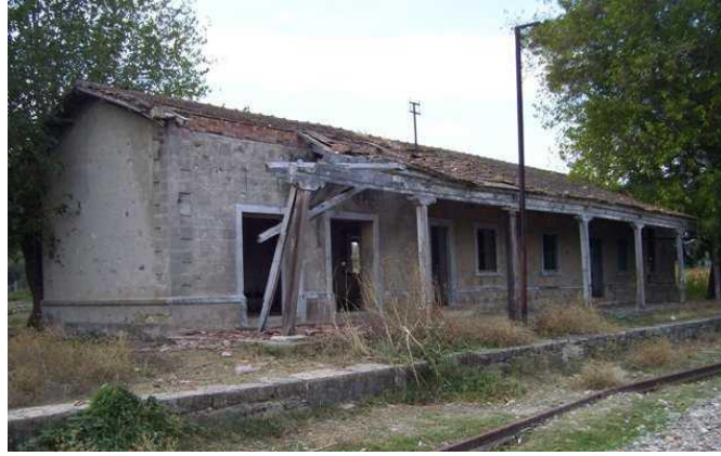
Şekil 5.92: Üzerlik İstasyonu Bekleme/İdare Binası ( https://kulturportali.gov.tr/turkiye/denizli/kulturenvanteri/tcddy-uzerlik-stasyonu-tesis-yapilari )
