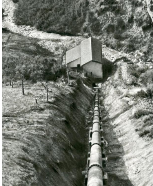
řekil 5.124: Gkpınar I Hidroelektrik Santrali (Denizli Bykřehir Belediyesi Arřivi)
