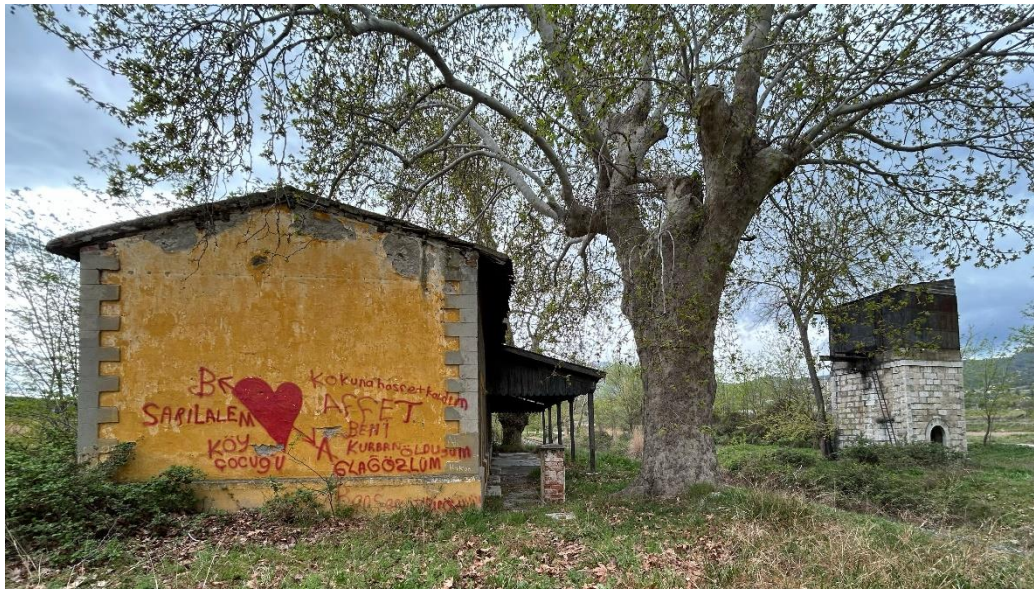
Şekil 5.105: İstasyon yapısı ve Su deposu (Yazar arşivi Mart 2025)
